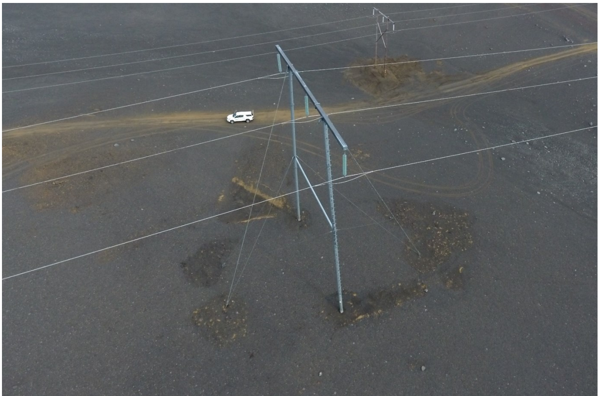
VIÐAUKAMYND A.5 Mastur 147 í KR3. Nýleg hjólför í sandinum eru vegna viðhalds á Kröflulínu 2.
