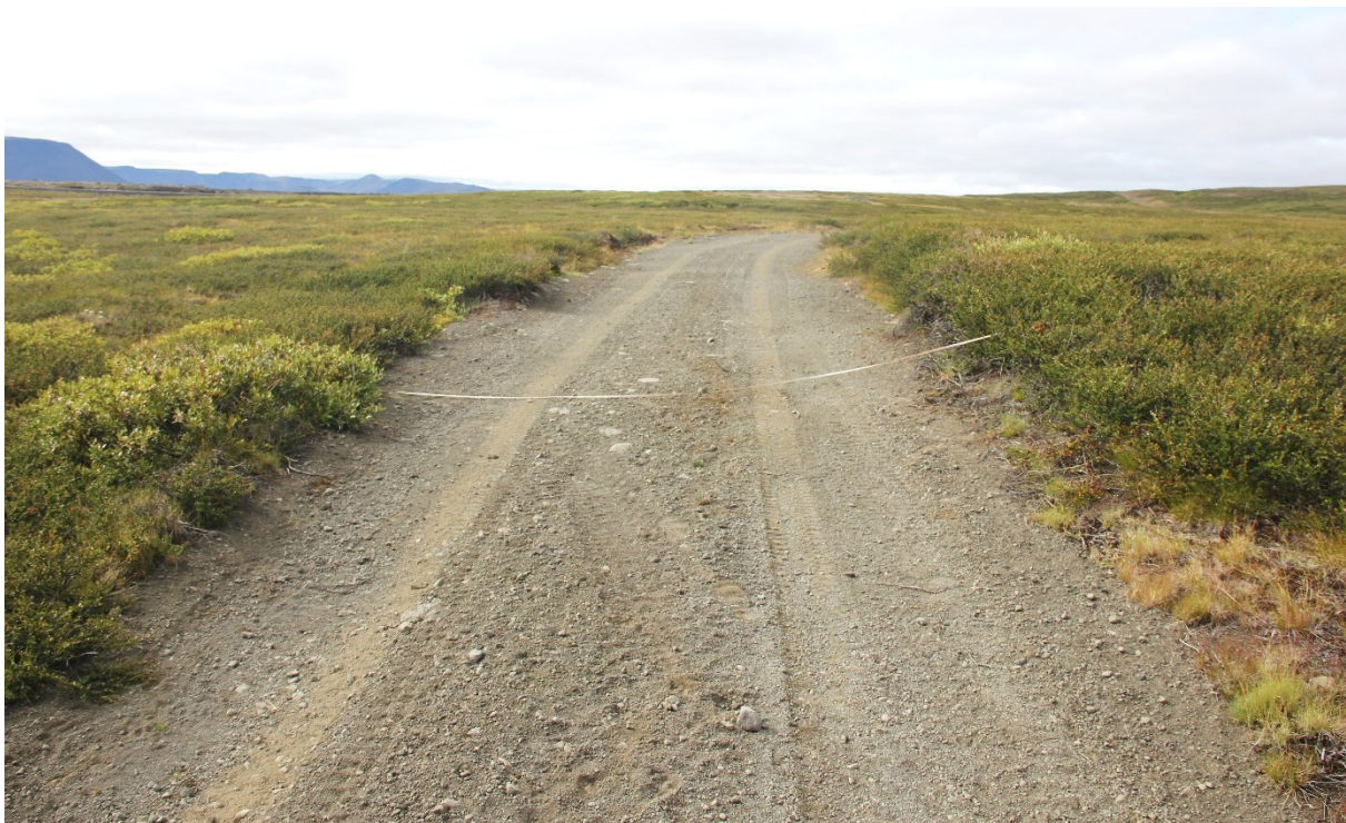
MYND 2.2 Eldri línuvegur, niðurgrafinn í mólendi, styrktur með nýju efni.
