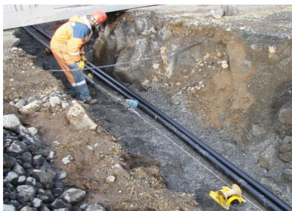
Mynd 3.12. Lagning háspennustrengja.
