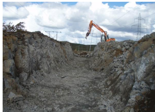
Mynd 3.1. Ólíkar aðstæður til jarðstrengslagnar. Fyrirhuguð strengleið í sandi á Suðurlandi (til vinstri). Strengskurður í hrauni við Hamranes (2007) (til hægri).
