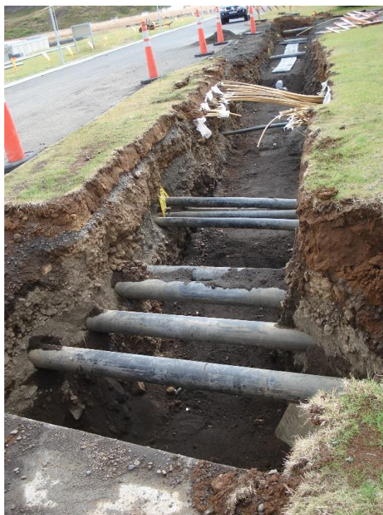
Mynd 3.8. Dæmi um lagnapverun, Nesjavallalína 2, nærri stöðvarhúsinu á Nesjavöllum.
