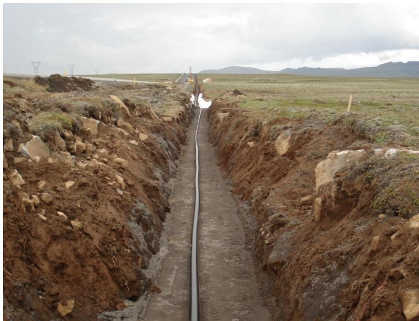
Mynd 3.3. Lagning 132 kV Nesjavallalínu 2 (2009) í hefðbundinn opinn skurð.
