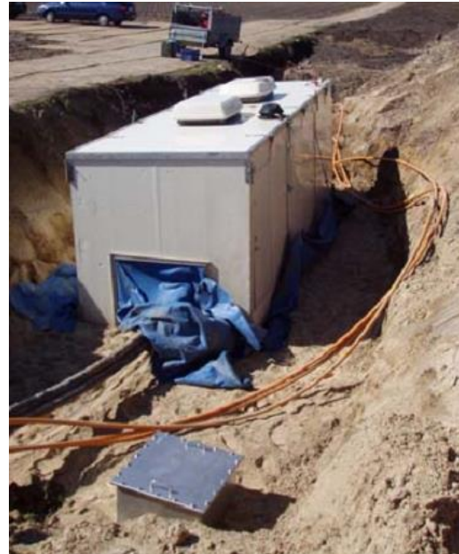
Mynd 3.13. Undirbúningur tengiholu á leið Nesjavallalínu 2 (til vinstri). Gámur notaður sem tengihús (Evrópa) (til hægri) (8).
