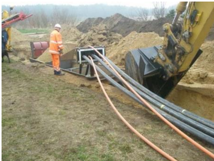
Mynd 3.5. Jarðstrengur lagður með aðstoð grafrarkassa í dönsku strengverkefni (8).
