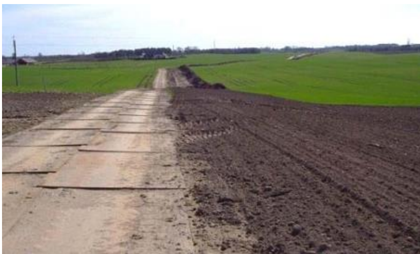
Mynd 3.11. Dæmi frá Evrópu, um notkun stálplatna sem þjónustuslóðar (8).
