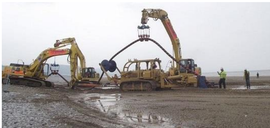
Mynd 3.4. Plæging jarðstrengs.
