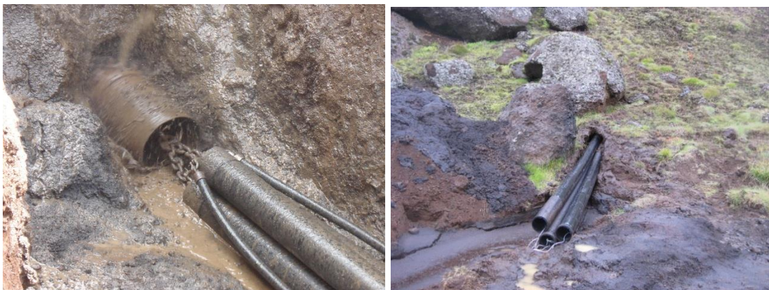
Mynd 3.10. Stefnuborun við Dyradali, vegna lagningar Nesjavallalína 2 (2009).
