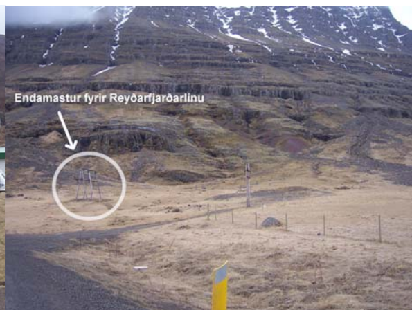
Mynd 7. Endamastur fyrir Reyðarfjarðarlínu frá Stuðlum. Hugsanlegt svæði undir 132 kV tengivirki á Eskifirði
