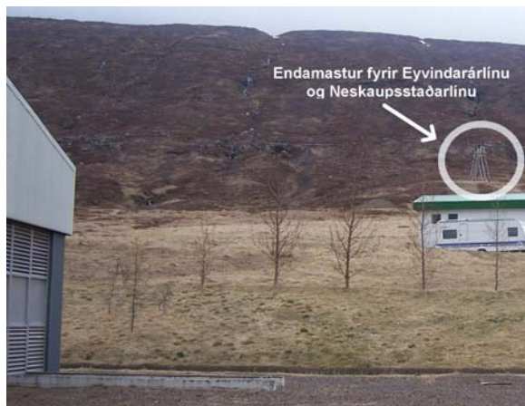
Mynd 6. Endamastur fyrir Eyvindarár- og Neskaupsstaðarlínu. 66 kV strengir tengja línur við innanhússtengivirki á Eskifirði.
