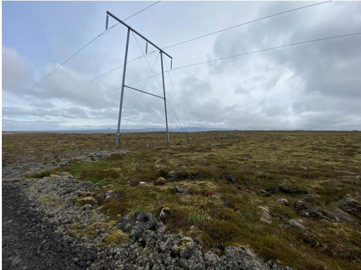
Mynd 7 Röramöstur Suðurnesjalínu 1, mastur 85.
